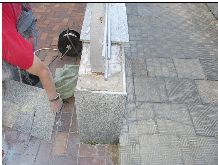
Кор.1-2, эт.1 Сухой ручей Восстановление облицовки парапета -подготовка поверхности -установка гранитной плитки
