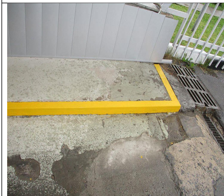
Кор.1, эт.-1, Пандус Окраска металлического уголка -окраска уголка
