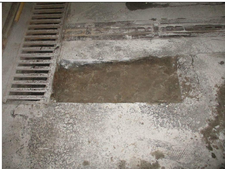
Кор.1, эт.-1 Заглубленный проезд Ремонт бетонных полов -приготовление и укладка бетонной смеси
