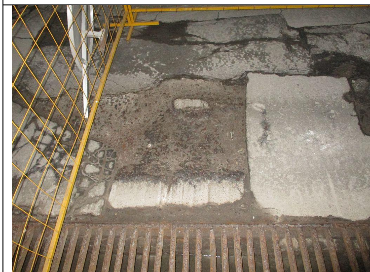
Кор.1, эт.-1 Заглубленный проезд Ремонт бетонных полов -подготовка полов к укладке бетона
