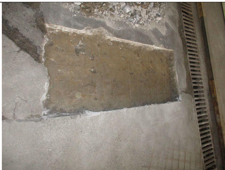
Кор.1, эт.-1 Заглубленный проезд Ремонт бетонных полов -приготовление и укладка бетонной смеси
