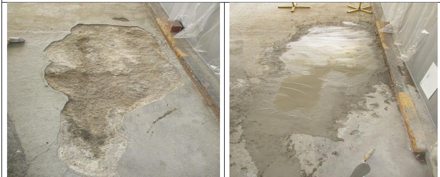
Кор.1, эт.-1 Пандус Ремонт бетонных полов -приготовление и укладка раствора
