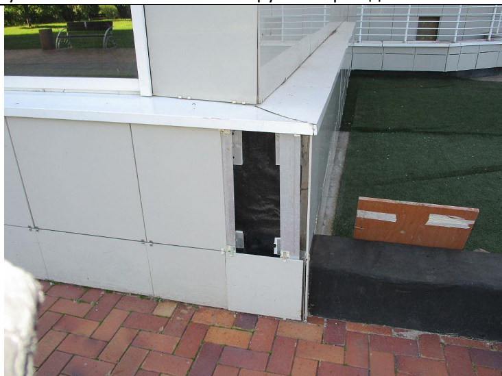
Кор.7, эт.1 Вентилируемый фасад Установка плитки на вентиляруемый фасад -установка плитки на вентиляруемый фасад
