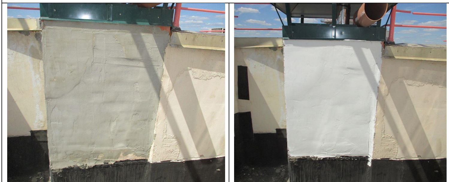
Кор.3, эт.35 Кровля Окраска шахты фановых труб -подготовка поверхности под покраску
