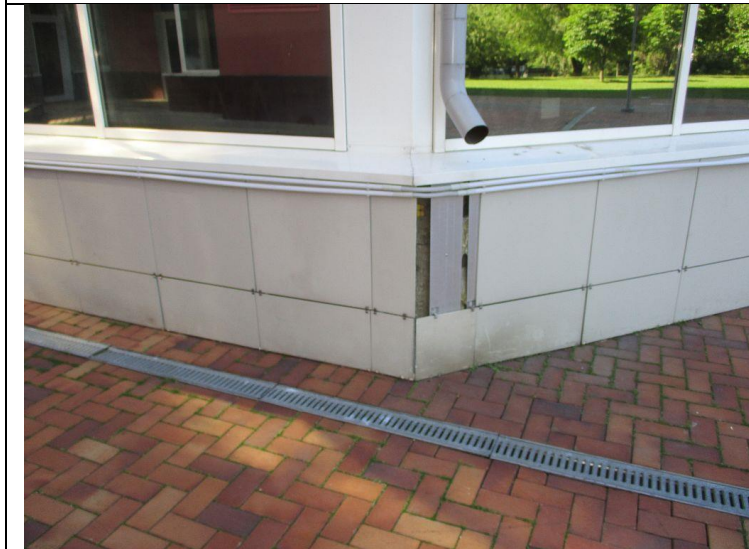
Кор.7, эт.1 Вентилируемый фасад Установка плитки на вентиляруемый фасад -установка плитки на вентиляруемый фасад
