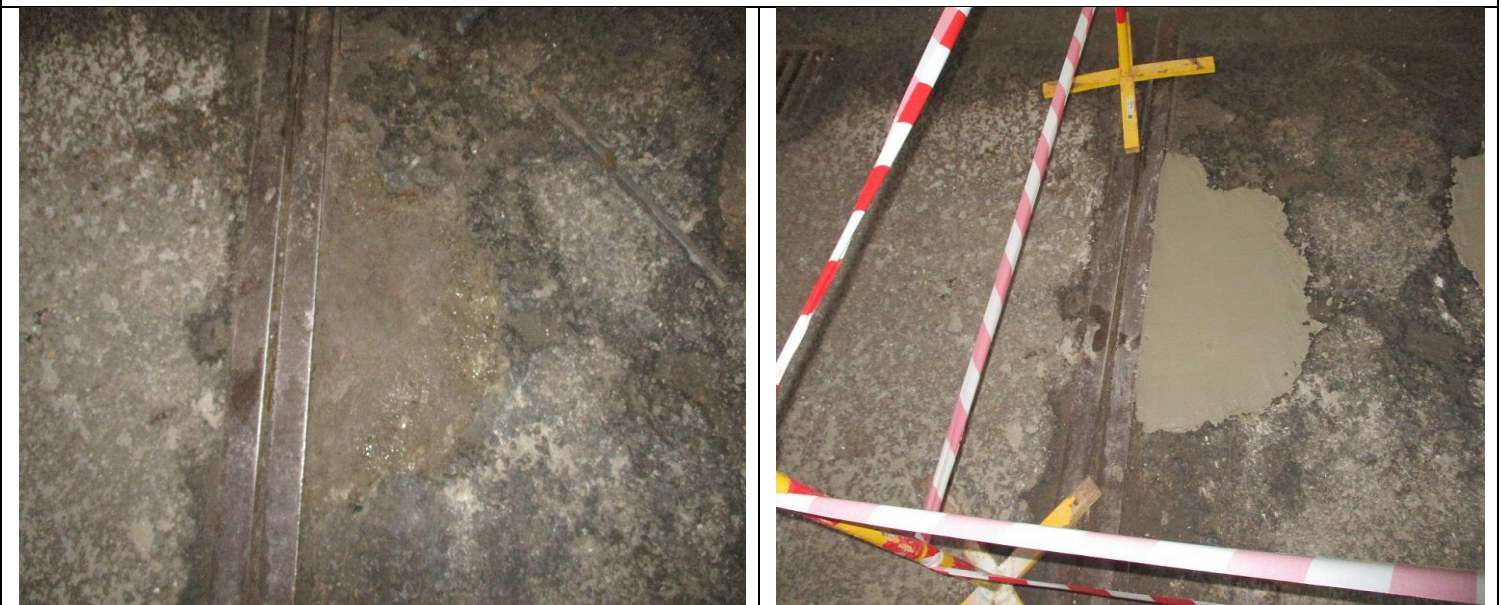
Кор.4, эт.-1 Заглубленный проезд Ремонт бетонных полов -приготовление и укладка бетонной смеси
