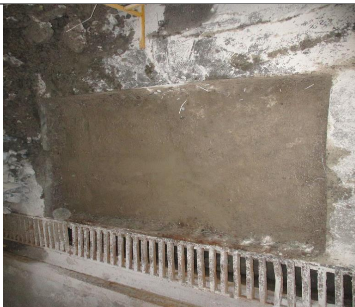
Кор.1, эт.-1 Заглубленный проезд Ремонт бетонных полов -приготовление и укладка бетонной смеси
