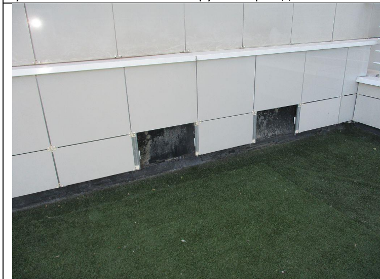
Кор.7, эт.1 Вентилируемый фасад Установка плитки на вентиляруемый фасад -установка плитки на вентиляруемый фасад
