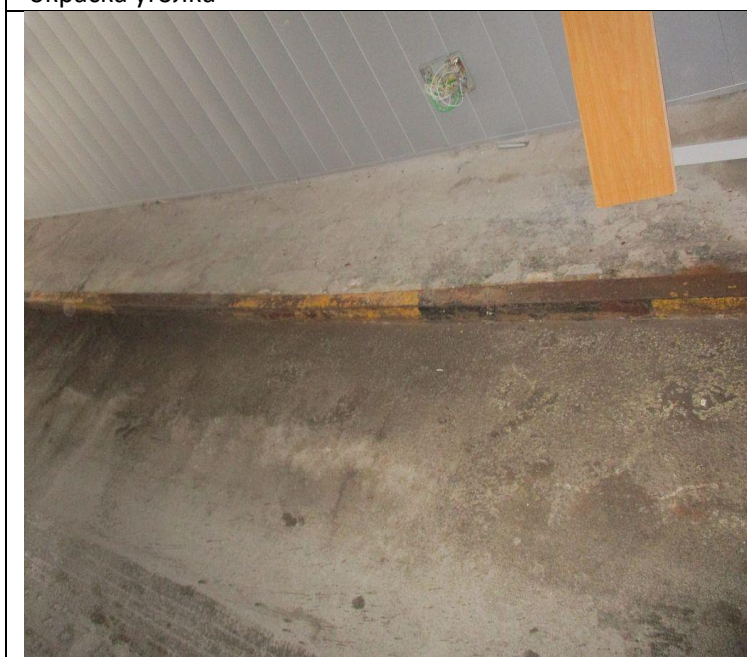
Кор.4, эт.-1, Пандус Окраска металлического уголка -зачистка металлического уголка -окраска уголка
