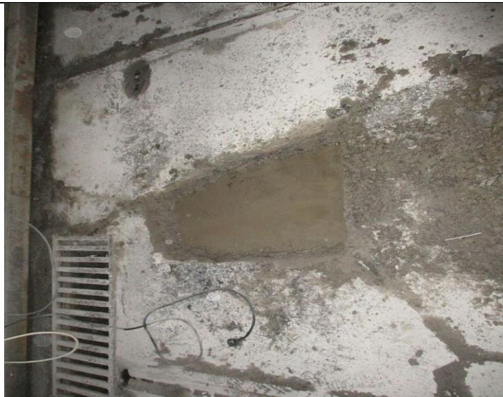
Кор.1, эт.-1 Заглубленный проезд Ремонт бетонных полов -приготовление и укладка бетонной смеси
