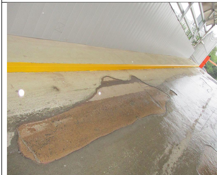
Кор.1, эт.-1, Пандус Окраска металлического уголка -окраска уголка
